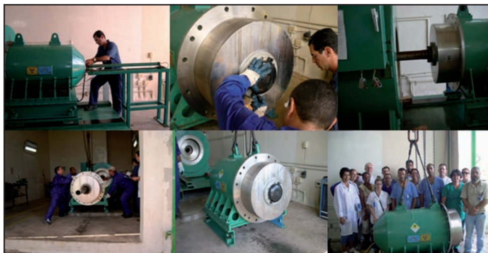
Figura 4. Operaciones más significativas en el desmantelamiento del GC- 500.
