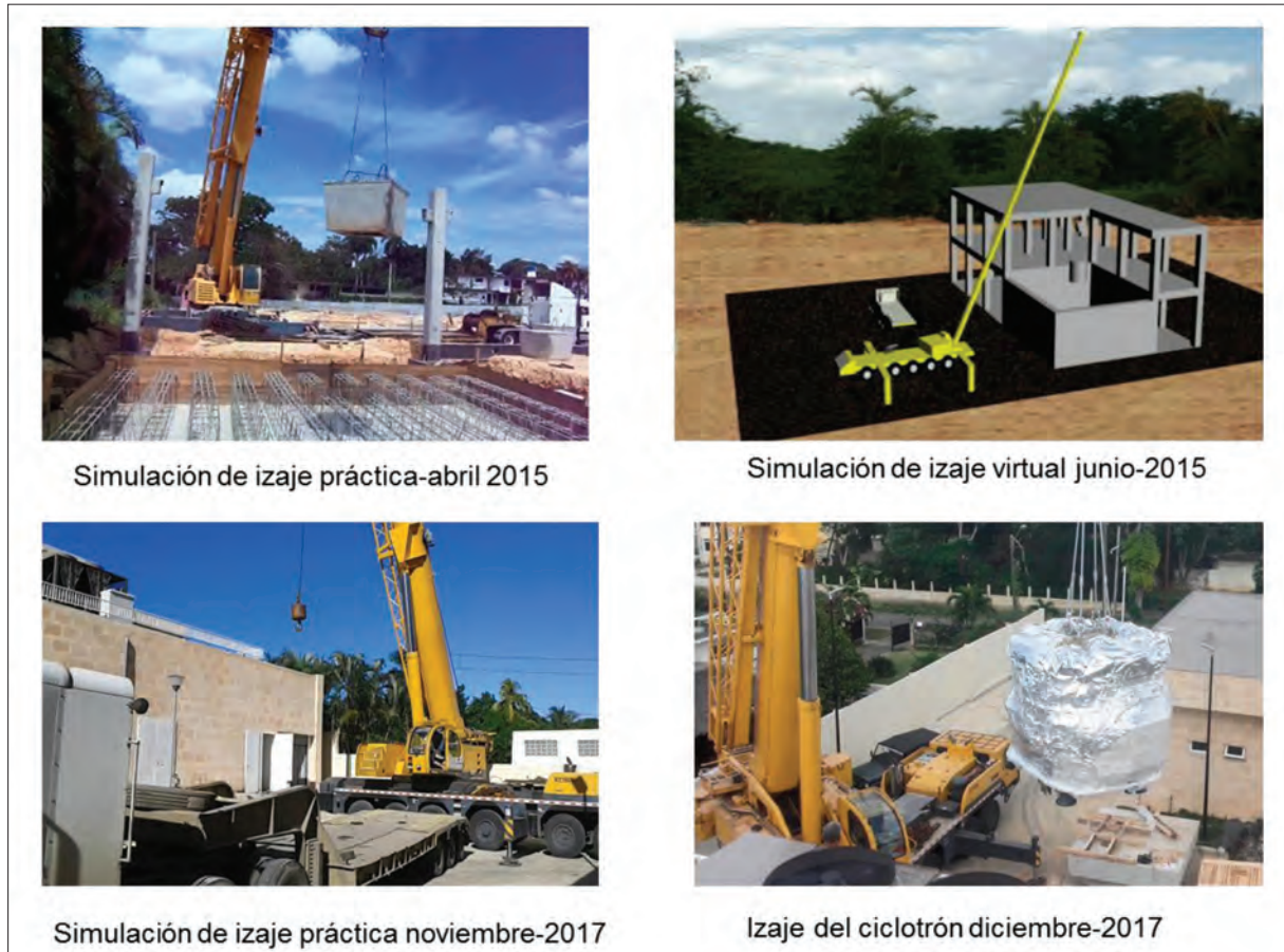
Figura 4. Izaje del Ciclotrón
